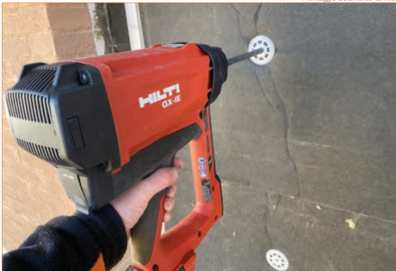
Montaggio isolamento termico
